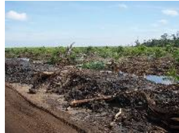
排水路から浚渫された土砂
